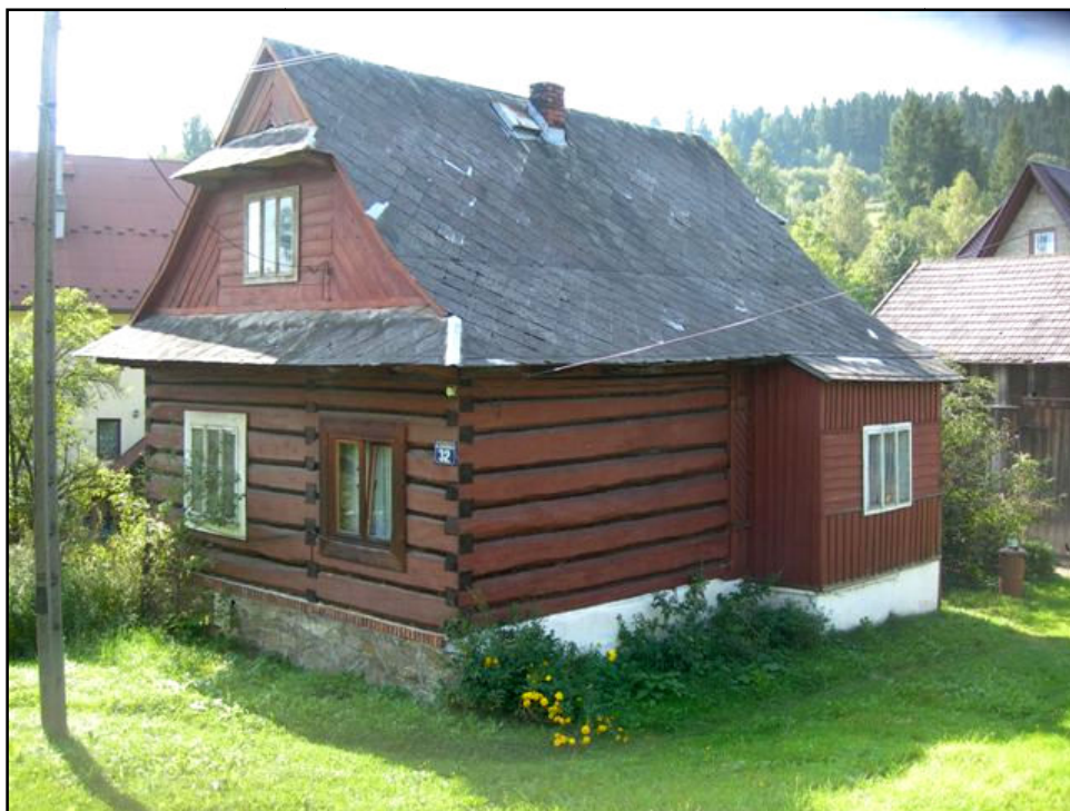
Rys. 3. Zdjęcie obrazujące wykorzystywanie wyrobów azbestowo-cementowych jako element pokrycia dachowego (płyty karo) źródło: zdjęcie własne – inwentaryzacja w terenie
